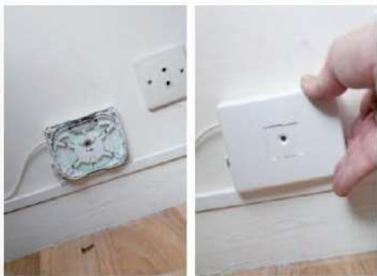
Prise terminale optique à l'intérieur du logement.
